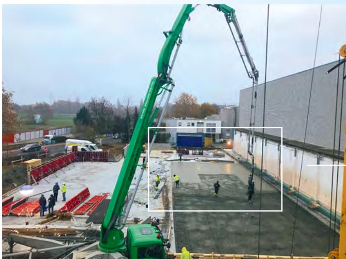
*Ende 2018 wurden die letzten Abschnitte der insgesamt 2.300 Quadratmeter umfassenden Grundfläche für das dritte Automatische Regallager gegossen. Der 40 cm dicke Betonboden wird von 360 je vier Meter tiefen Betonsäulen gestützt, um die benötigte Kapazität von 5.800 Tonnen für Lagergut und Betriebsstoffe tragen zu können.*
